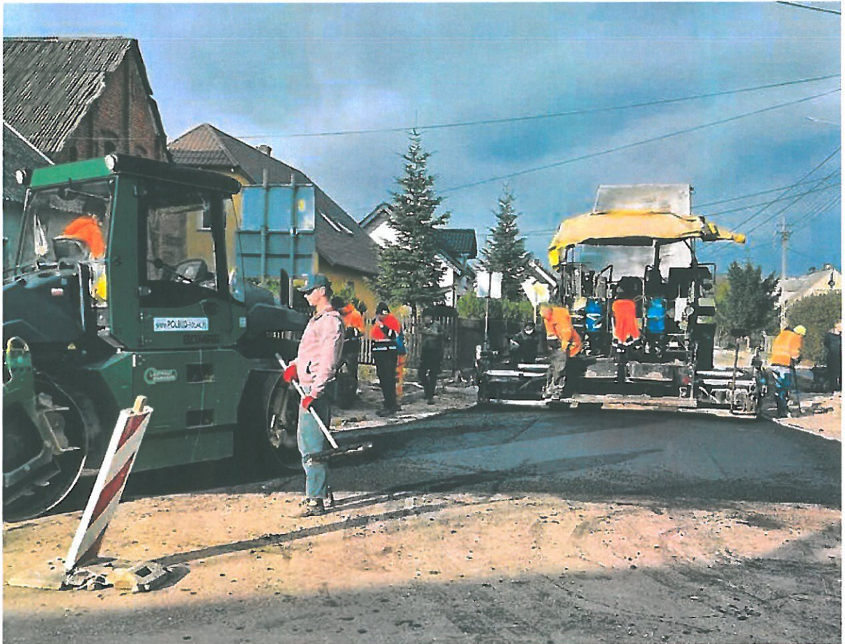
Modernizacja drogi gminnej 52/1 w miejscowości Sławsko Dolne
