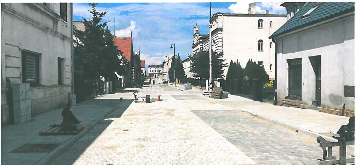
Budowa kanalizacji sanitarnej i deszczowej oraz nawierzchni drogi ulicy Gimnazjalnej i Magazynowej do skrzyżowania z ul. Spichrzową – w trakcie prac
