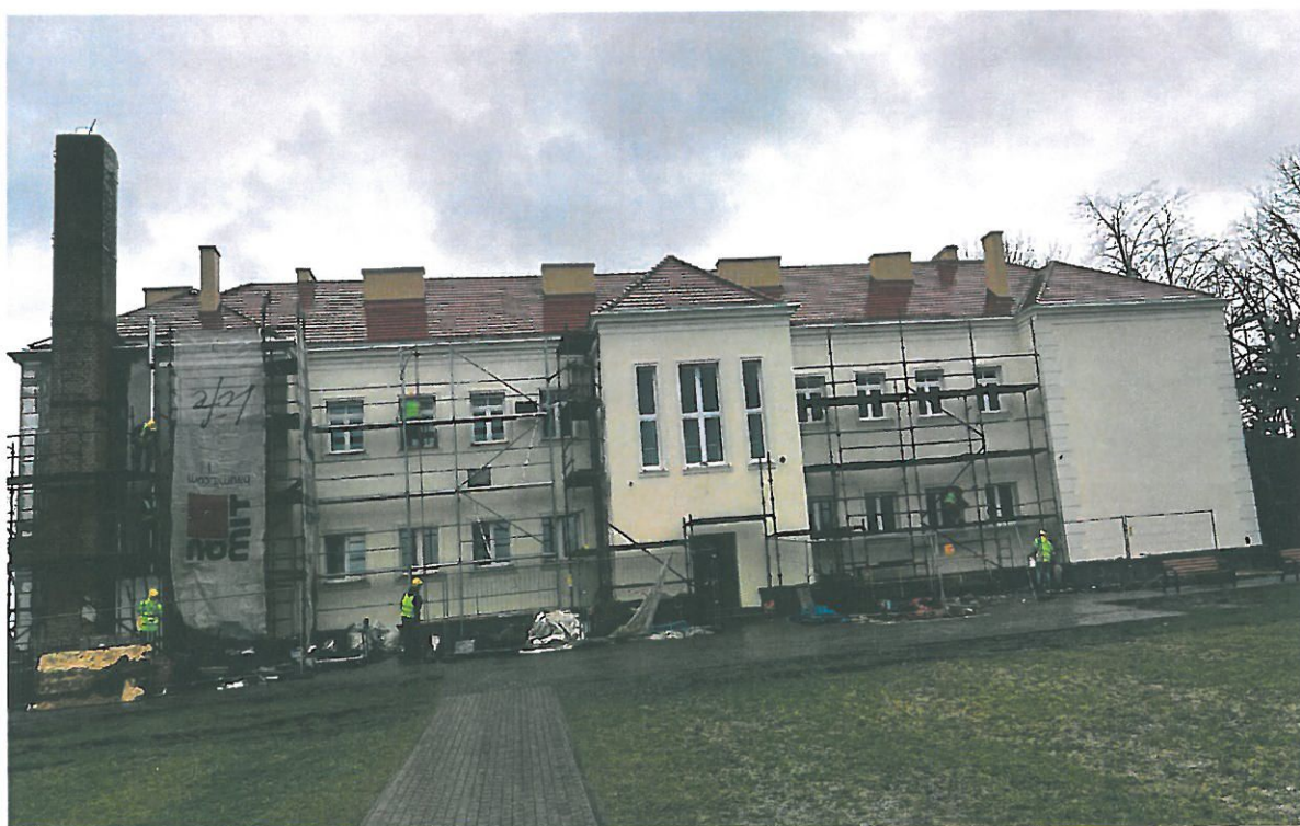
Termomodernizacja Szkoły Podstawowej im. Gustawa Zielińskiego w Markowicach
